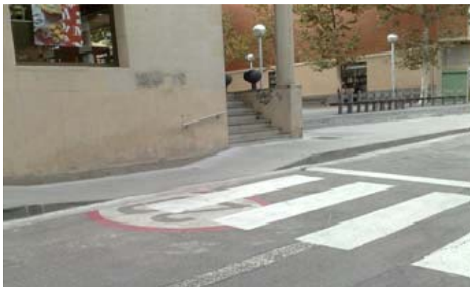
Av. Montserrat - Xic Mateu: Acera mal construida, con alturas y ángulos de paso fuera de ley. Suelo calle sin tapar señales anteriores
